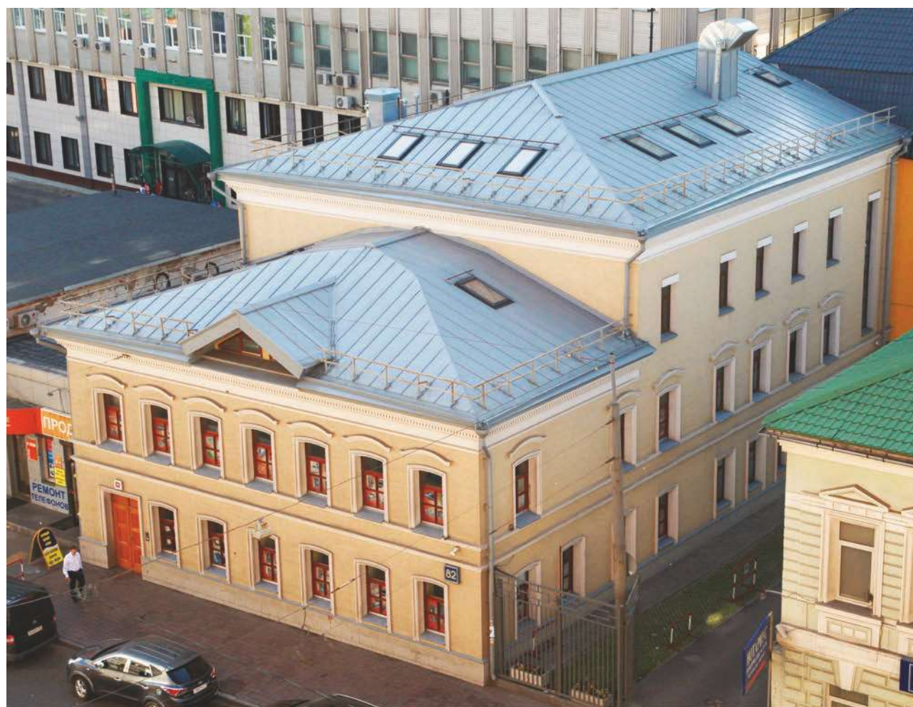
Офисное здание XIX века, ул. Бауманская
